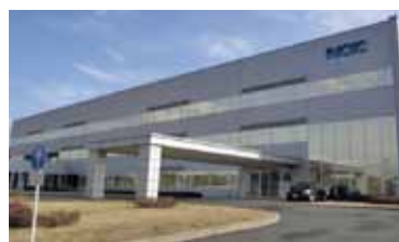
遮熱フィルム施工
